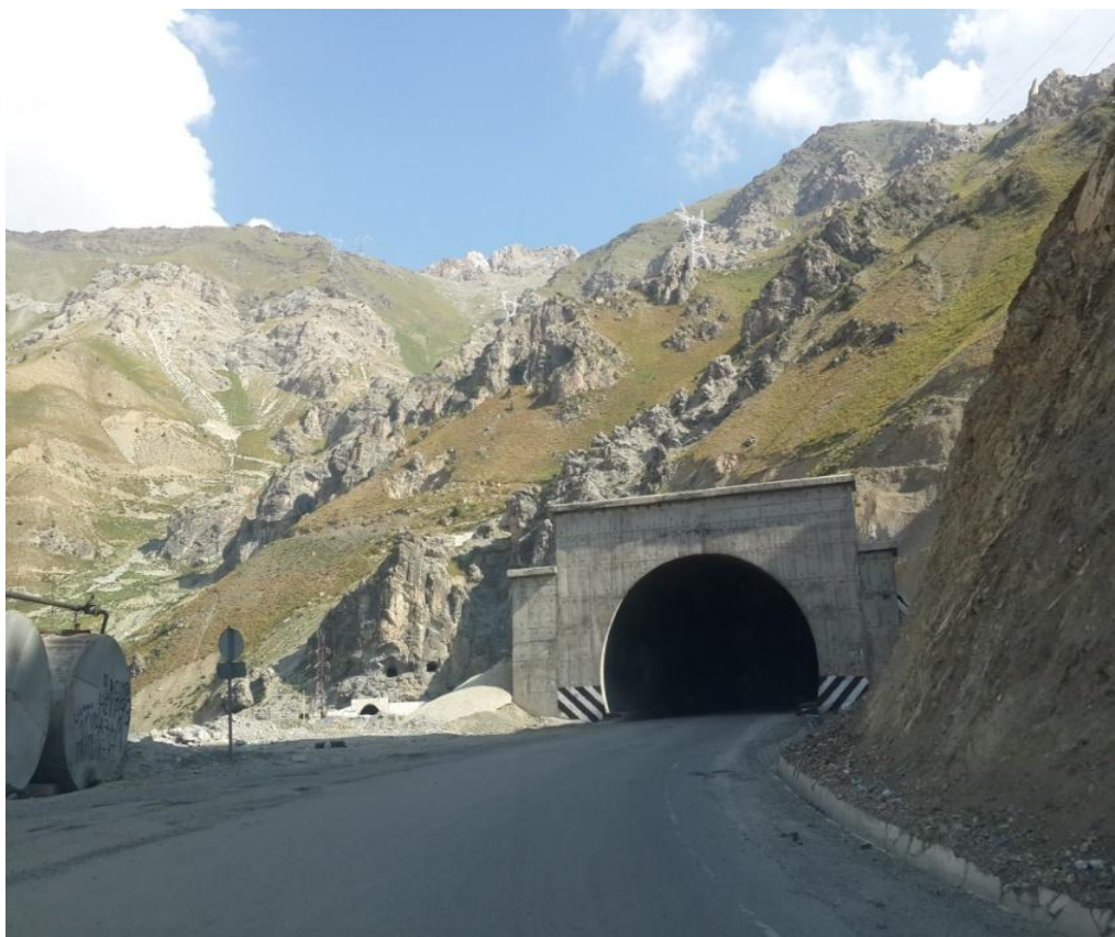
Рис. 2. Противолавинная галерея на 75 км автодороги Душанбе-Худжанд
