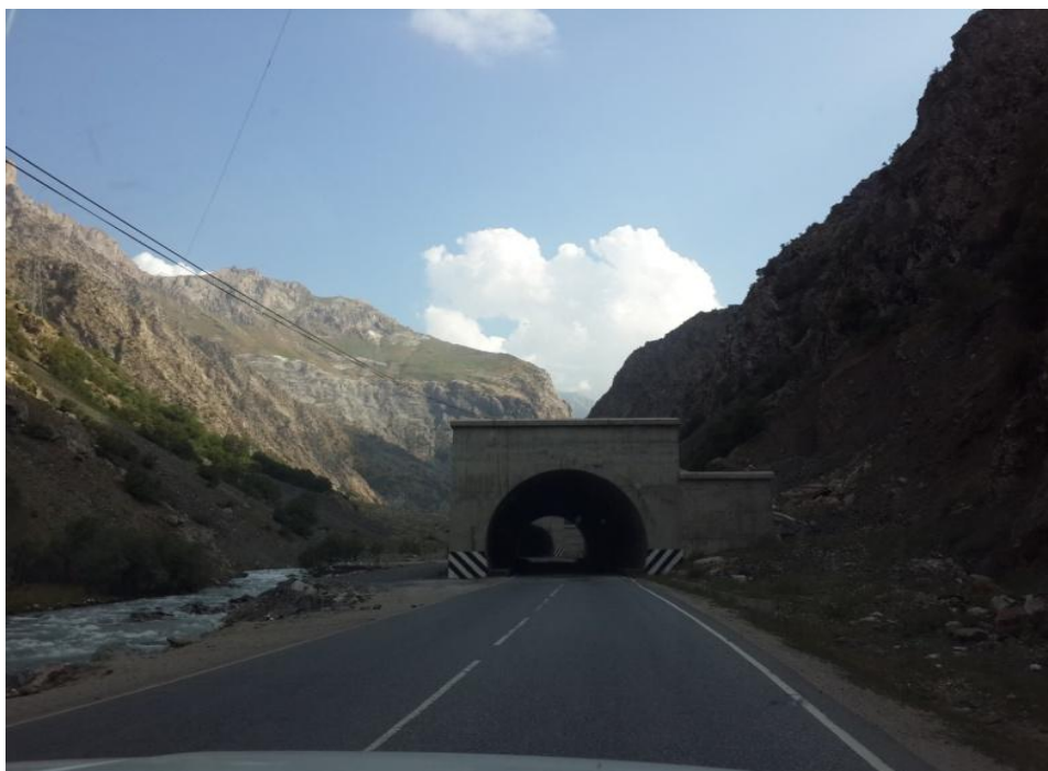
Рис. 1. Противолавинная галерея на 51 км автодороги Душанбе-Худжанд
