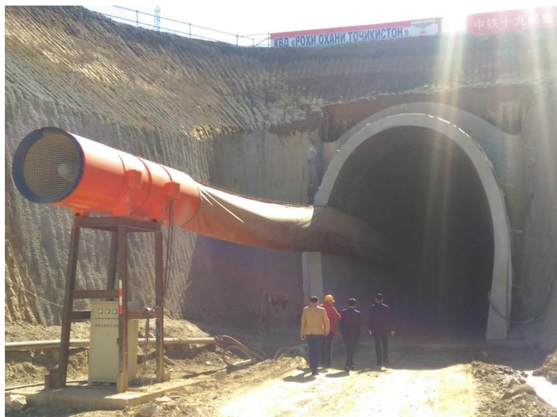
Рис.1. Западный портал железнодорожного тоннеля
