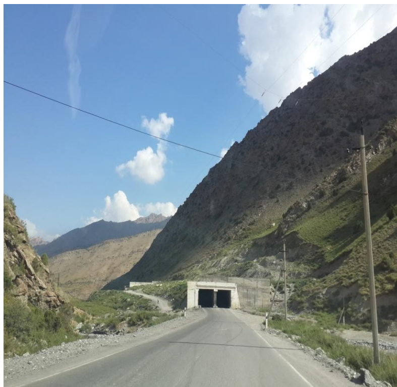
Рис. 3. Противолавинная галерея на 81 км автодороги Душанбе-Худжанд
