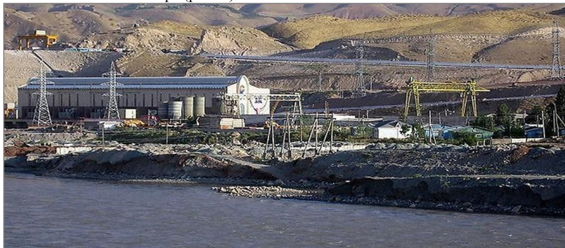
Рис. 2. Геориски от подмыва правого берега в нижнем бьефе Нурекского водохранилища, 2015 г.
