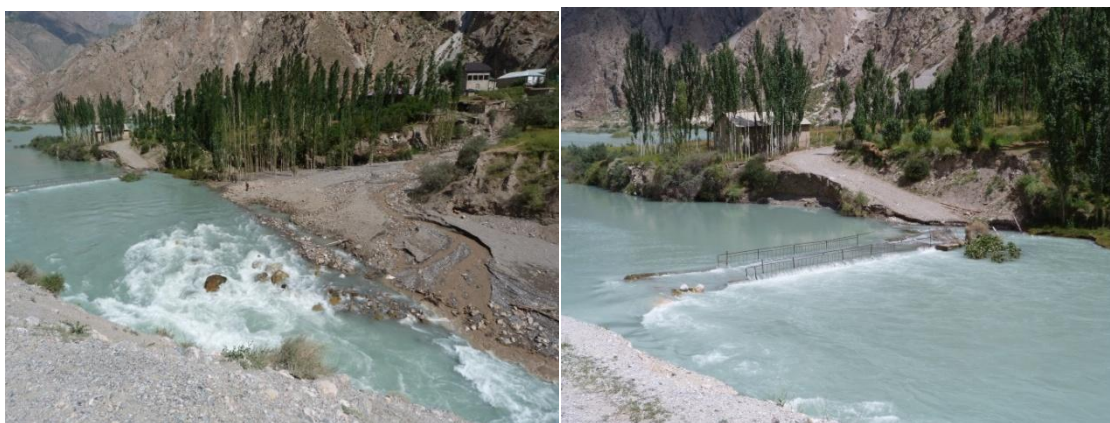
Рис. 10. Временное перекрыти селевыми отложениями русла р. Ягноб
