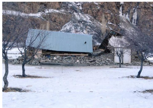
Рис.9. Полное разрушение здания медпункта
