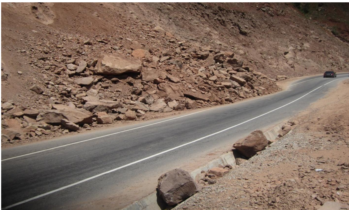
Рис. 3. Сползание недостаточно спланированного верхового откоса
