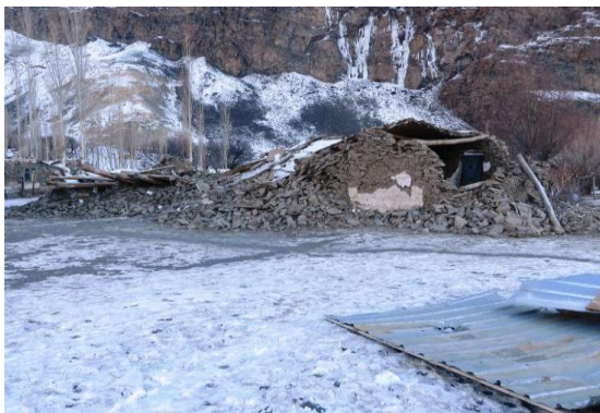
Рис.8. Полное разрушение здания клуба
