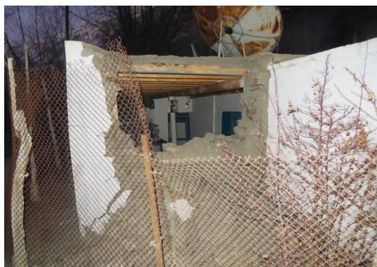
Рис.11. Частичное повреждение каменных стен от землетрясения
